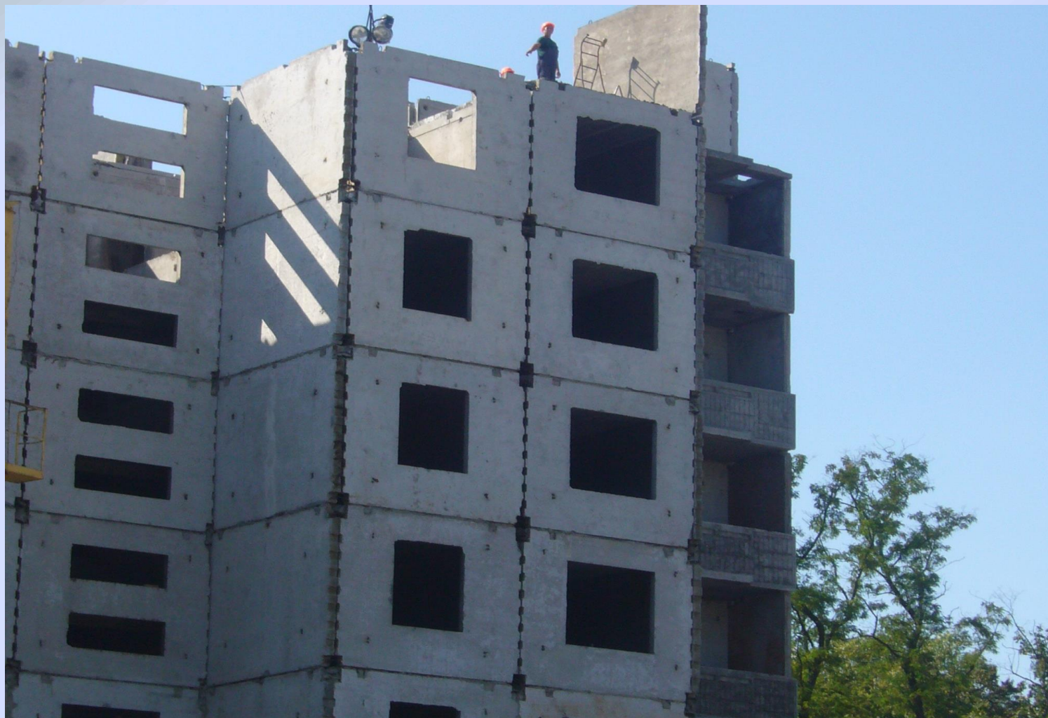
Монтаж будинку-представника в м. Василькові.
