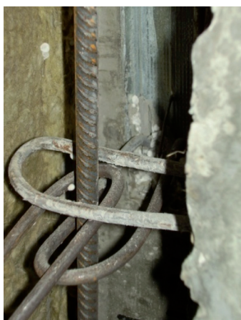
Рис. 3. Великопанельний будинок з конструкціями, виготовленими за екструзійною («фінською») технологією: а - автоматизована лінія з виробництва екструзійних залізобетонних плит; б - випробування фрагмента будівлі в ДП НДІБК; в - петлевий стик 9-поверхового панельного будинку; г - загальний вигляд побудованого будинку за вул. Ніканорова в Сімферополі.
