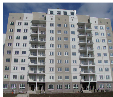
Рис. 3. Великопанельний будинок з конструкціями, виготовленими за екструзійною («фінською») технологією: а - автоматизована лінія з виробництва екструзійних залізобетонних плит; б - випробування фрагмента будівлі в ДП НДІБК; в - петлевий стик 9-поверхового панельного будинку; г - загальний вигляд побудованого будинку за вул. Ніканорова в Сімферополі.
