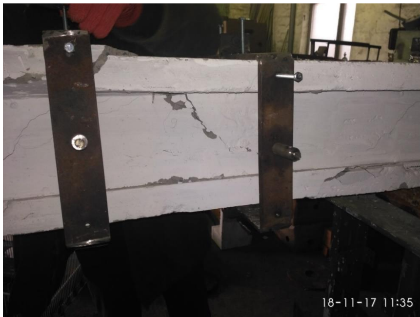
Рис. 9. Загальний вигляд руйнування (балки без нормальних тріщин).
