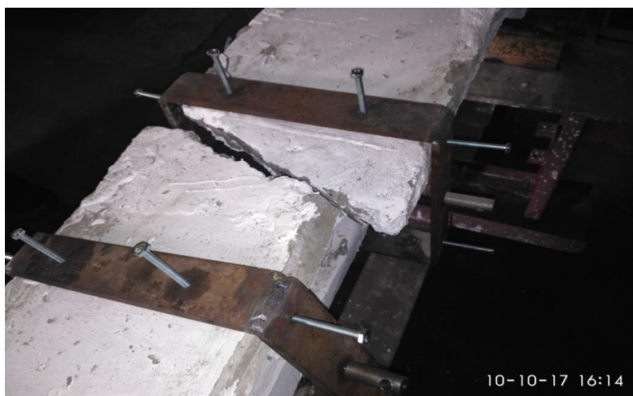
Рис. 7. Загальний вигляд просторової тріщини руйнування верхньої полиці
