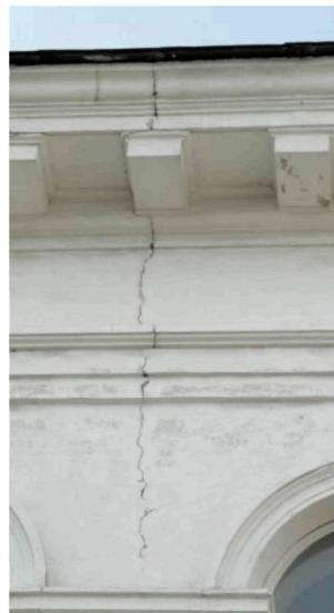
Рис.3.15 Вертикальна тріщина в карнизній частині цегляного простінка (2012 р.)
