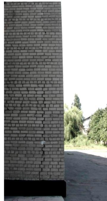
Рис. 1.5 Тріщина ширину розкриття до 1 см в нижній частині стіни центрального вітражу Центру дитячої творчості «Мрія» в результаті дії промислових вибухів кар'єра ВАТ «Південний ГЗК» в м. Кривий Ріг (2008 р.)
