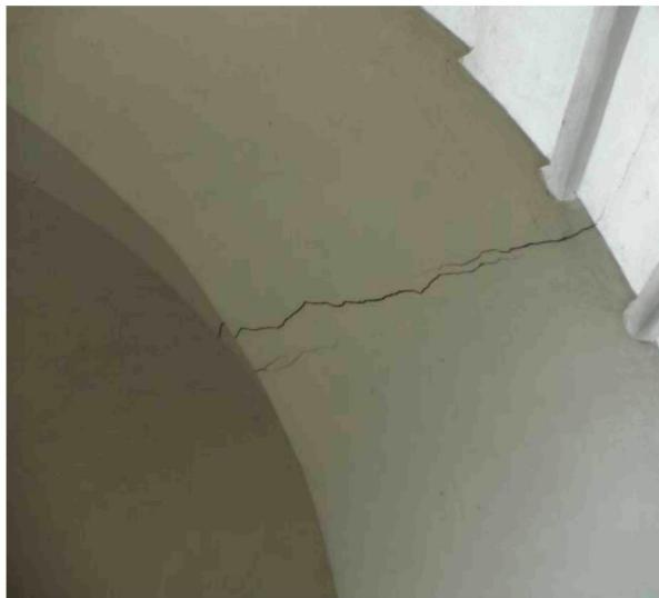
Рис. 3.14 Тріщина в цегляній склепінчастій перемичці по осі Л із шириною розкриття до 1,5 мм (2012 р.)
