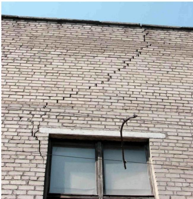
Рис. 1.4 Тріщина ширину розкриття до 1 см у верхній частині стіни фасаду Центру дитячої творчості «Мрія» в результаті дії промислових вибухів кар'єра ВАТ «Південний ГЗК» в м. Кривий Ріг (2008 р.)
